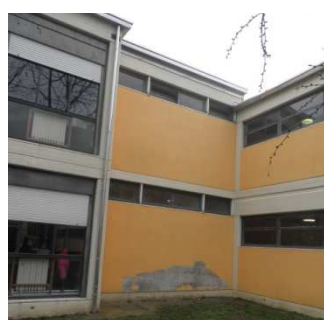
Figura 6.18: corpo aule posteriori, porzione in muratura portante nel prospetto sud-est
