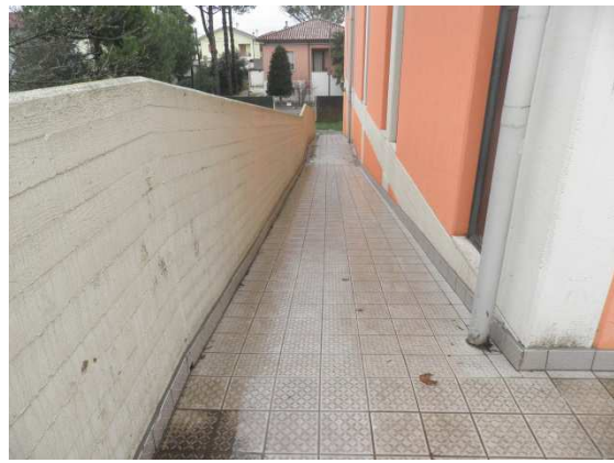
Figura 6.31: Rampa a sbalzo in calcestruzzo armato
